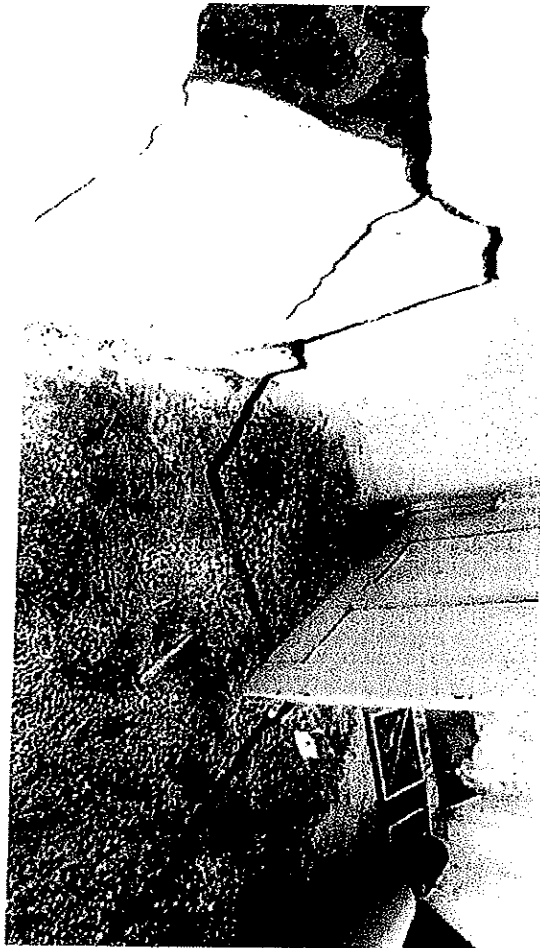
Foto nr=2 Ulje dyshemeje ne dhome dhe carje horizontale dhe vertikale ne dhome 5-10 cm
